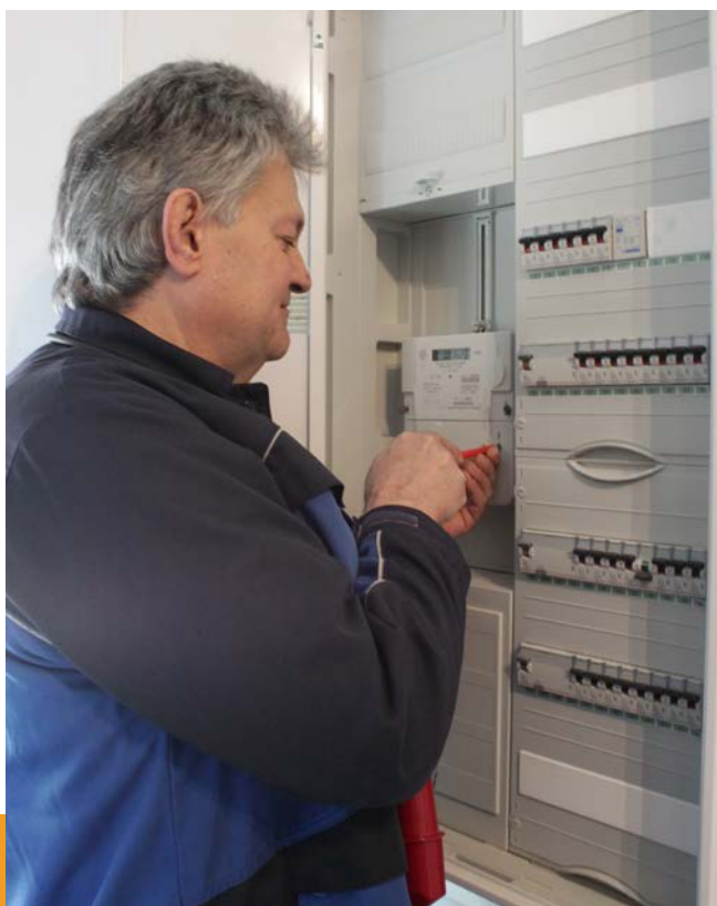
Ralf-Dieter Kappel, Netzmonteur im Netzbetrieb Strom, an einem elektronischen Zähler. Foto: Katja Cierpinsky.
